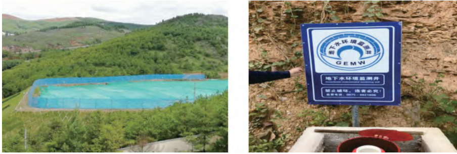
图 3.3-2 尾矿库管理及环保标识标志专项排查
